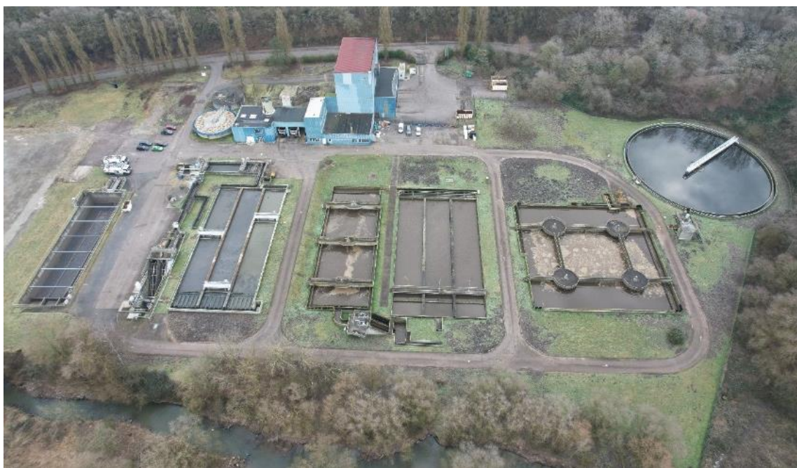
Photographie aérienne de l'unité de traitement actuelle
