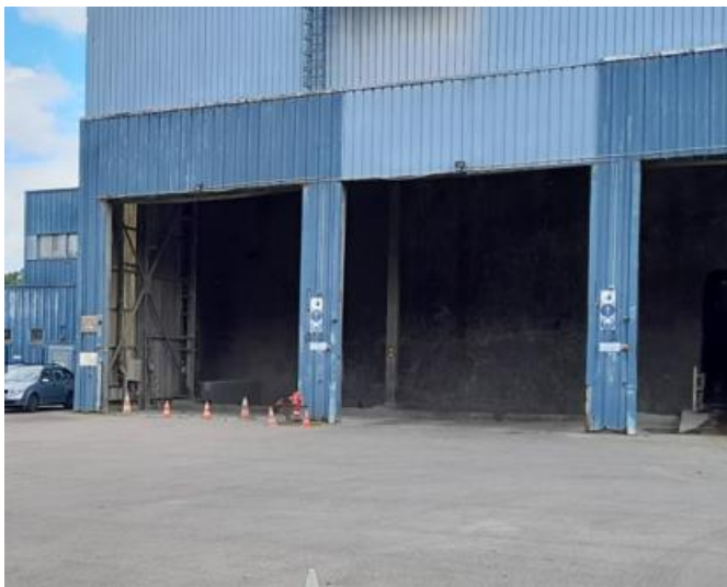
Quai de transfert déchets
