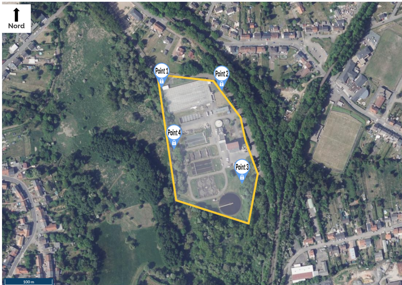
Vue du périmètre du site
