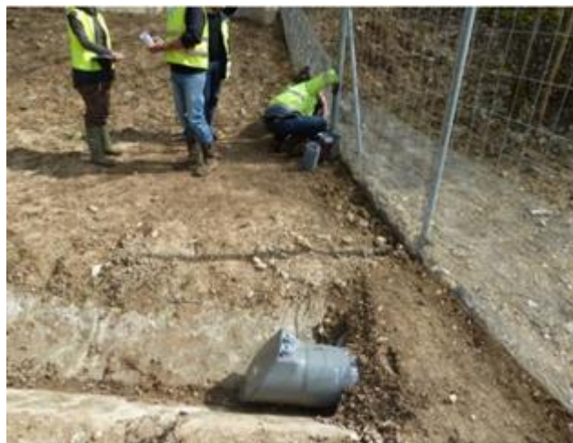
Exemple de grillage à maille fine installé au bas d'un grillage à maille large
