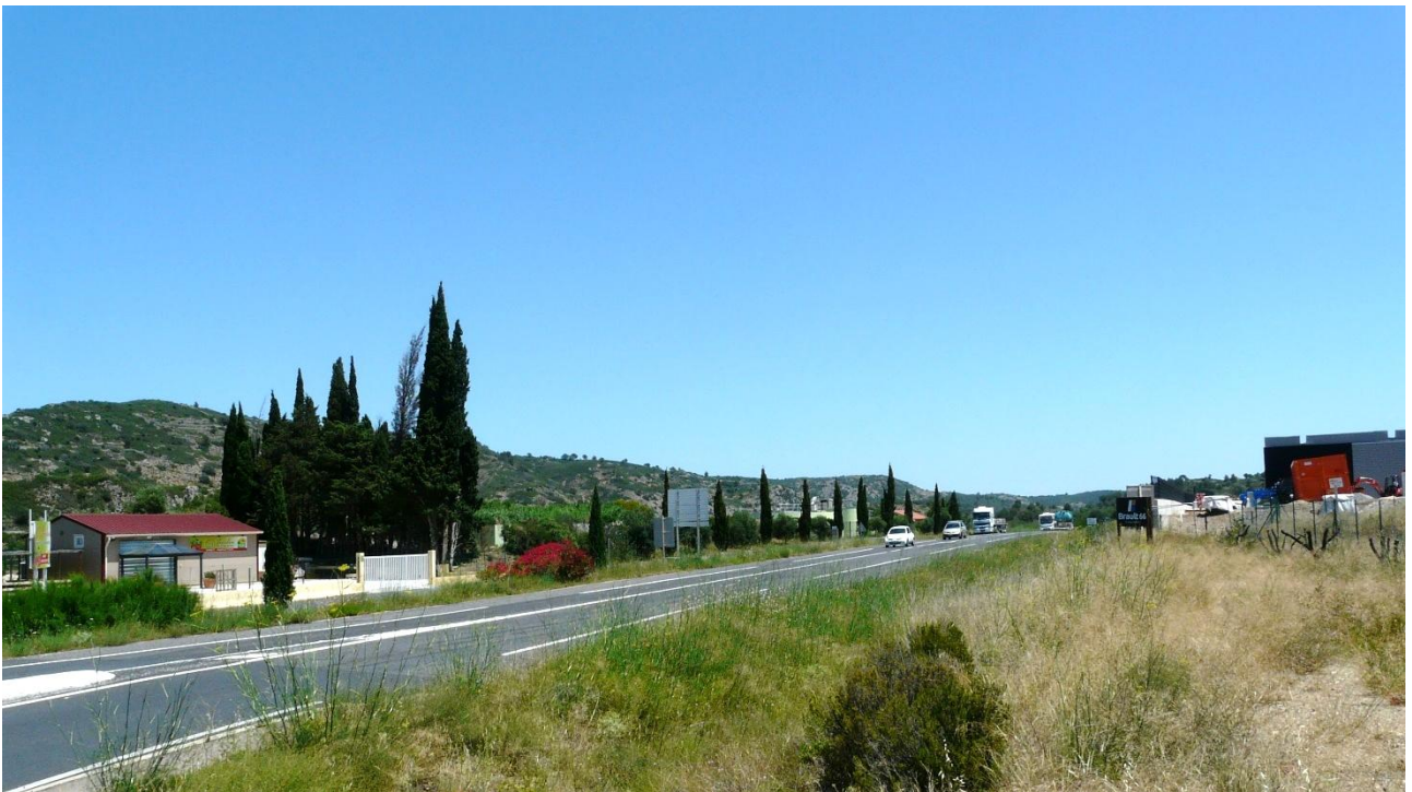
A gauche de la RD117 : Commerce de produits locaux et au fond station d'épuration d'Estagel
