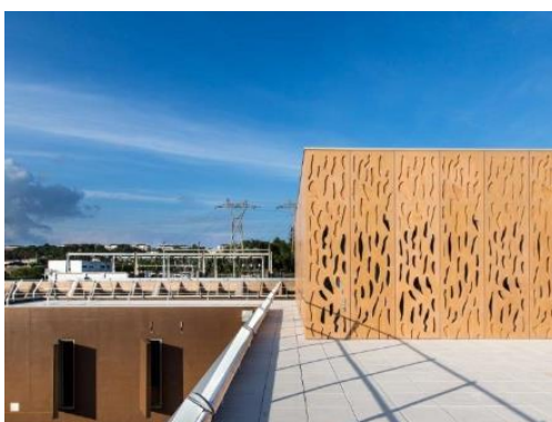
Figure 7 : Poste source électrique de Saint-Raphaël
