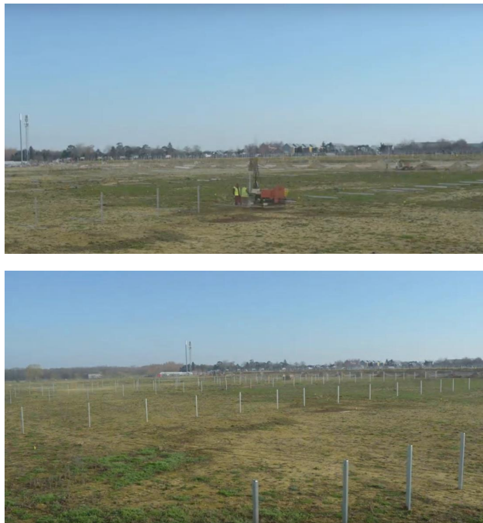
Photo 3 : Mise en place des pieux battus - photos de la construction de la Ferme Solaire Marc Energies, une réalisation IEL
