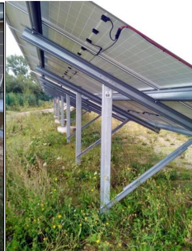
Photo 1 : Câblage des panneaux photovoltaïques
