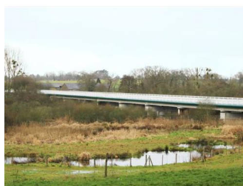
Figure 10 : Viaduc Dol de Bretagne
