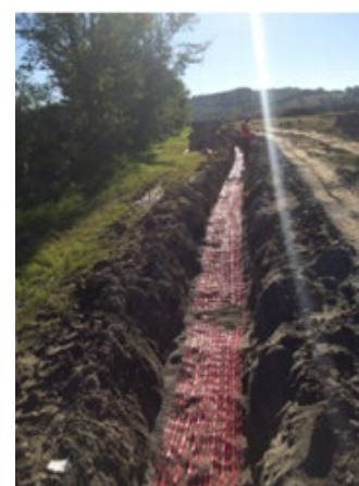
Figure 37. Tranchée avec grillage avertisseur (source : Valeco)
