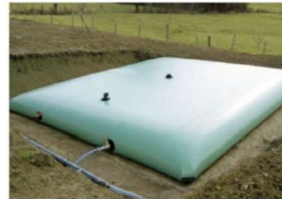
Figure 9 : Exemple de réserve d'eau artificielle souple
