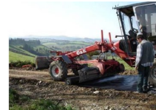
Figure 21 et Figure 22. Tracé de la piste et Pose du géotextile (source : Valeco)
