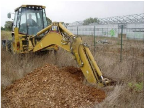
Figure 15 et Figure 16. Sondage à la pelle et Fouille de sondage (source : Valeco)
