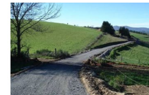
Figure 23 et Figure 24. Mise en place du gravier (source : Valeco)
