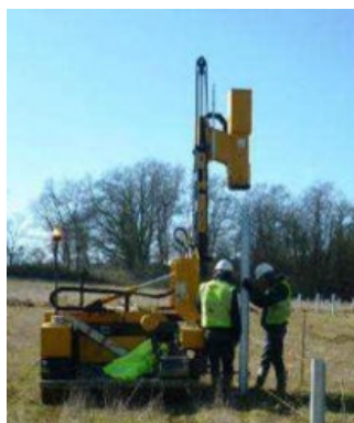
Figure 25. Battage des pieux (source : Valeco)
