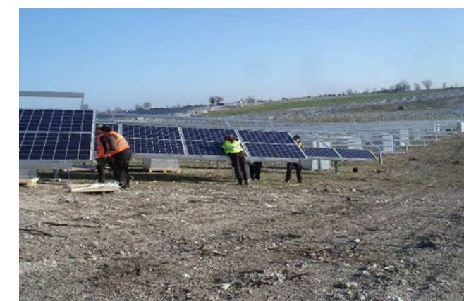
Figure 29. Pose des modules, centrale solaire de Cahors - 46 (source : Valeco)
