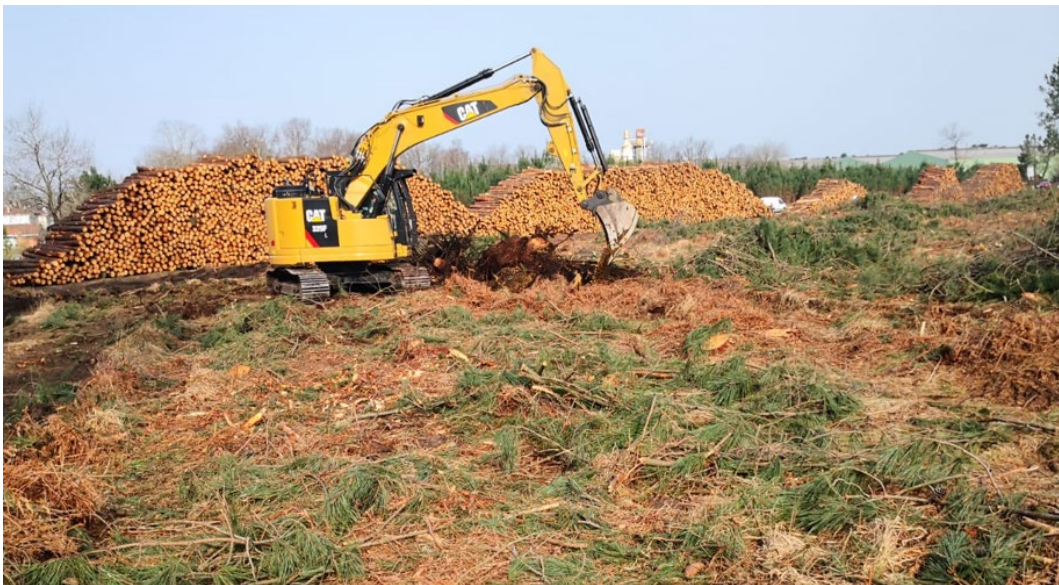
Figure 19. Dessouchage avec pelle mécanique (source : Valeco)
