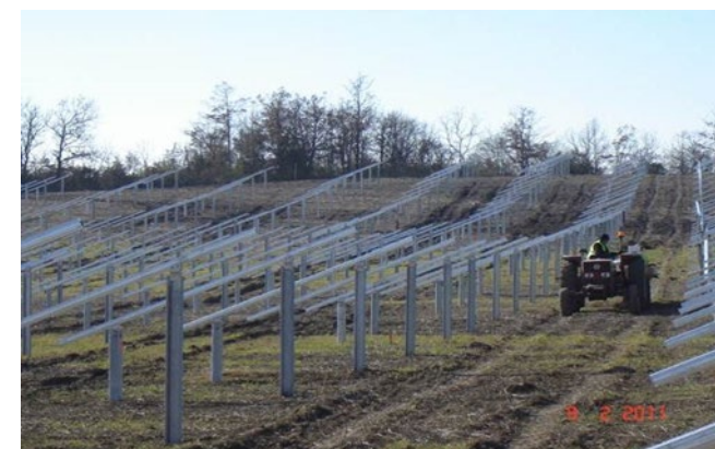
Figure 27. Fixation des adaptateurs (source : Valeco)
