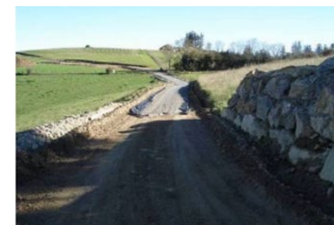
Figure 23 et Figure 24. Mise en place du gravier (source : Valeco)
