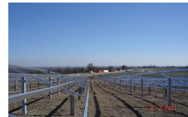
Figure 28. Fixation des rails de support (source : Valeco)
