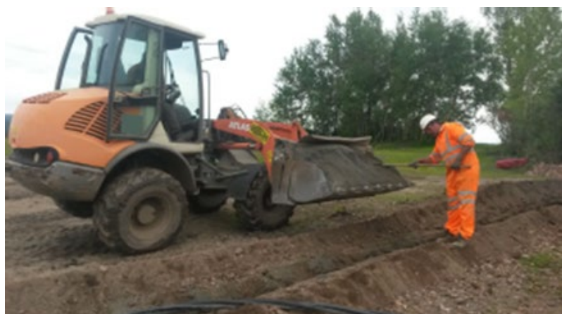
Figure 36. Réalisation de tranchée pour enterrément des câbles (source : Valeco)
