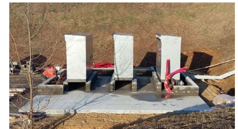
Figure 34. Poste de transformation en construction (2 onduleurs, 1 transformateur et enveloppe béton à venir) (source : Valeco)
