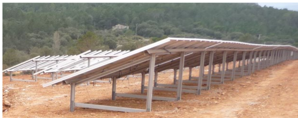
Figure 26. Pose des structures support à pieux vibrofoncés (source : Valeco)
