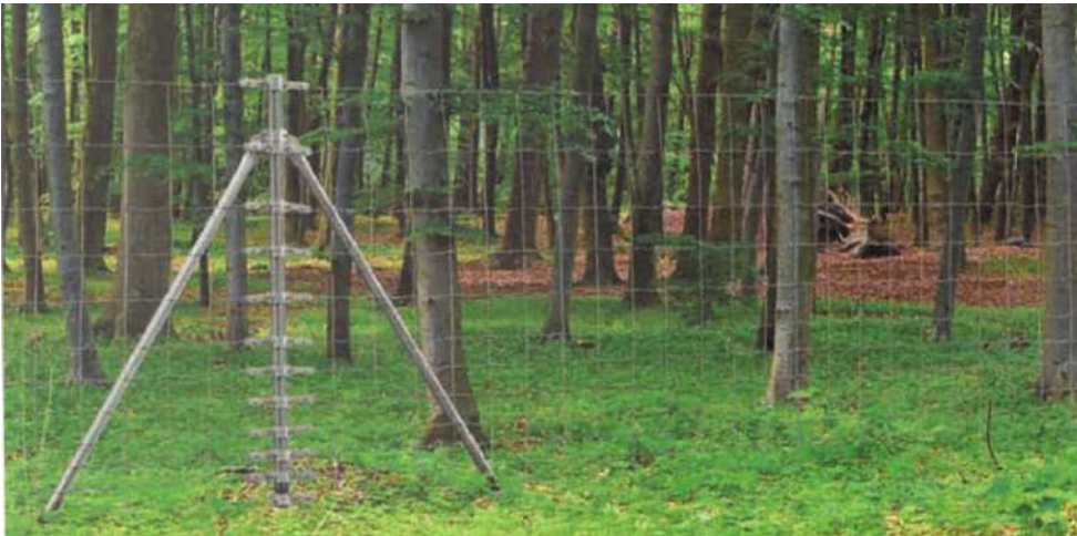
Illustration 28. Photographie d'une clôture (source : Valeco)
