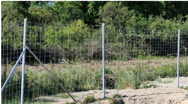
Figure 25 -Clôture à mailles progressives à Argent-sur-Sauldre (18)
