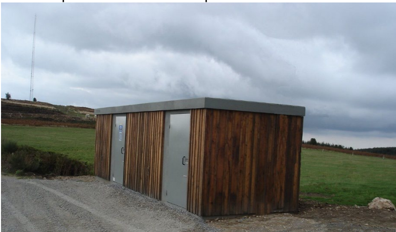
Figure 23 Photographie d'un poste de transformation/livraison en bardage bois
