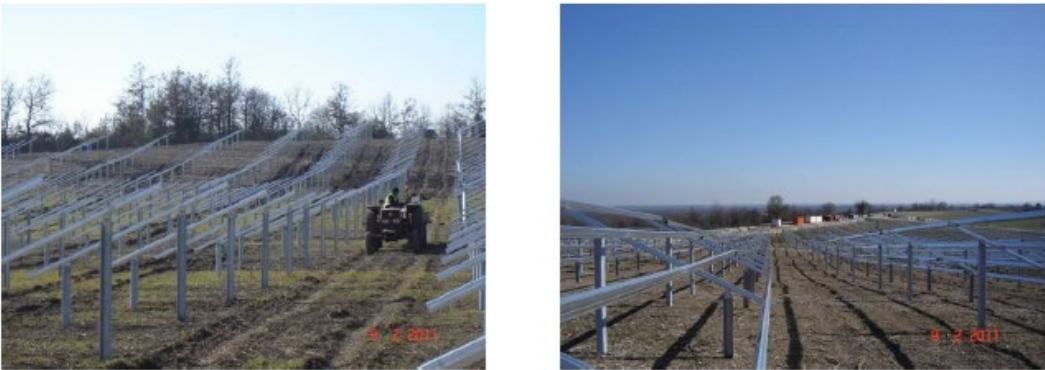
Figure 32 : Montage des structures porteuses
