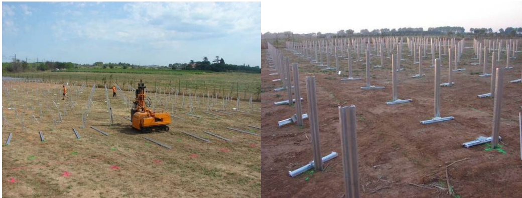
Figure 31 : Exemple de pieux battus et forés bétonnés
