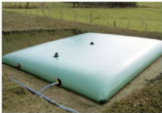
Figure 24 : Exemple de réserve d'eau artificielle souple
