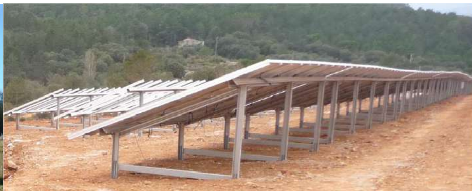
Pose des structures support à pieux vibrofoncés
