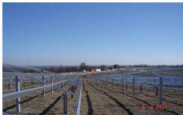
Fixation des rails de support
