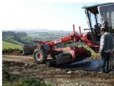
Pose du géotextile
