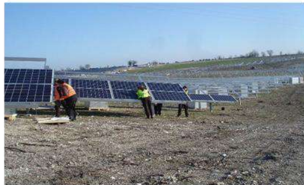
Pose des modules, centrale solaire de Cahors (46)
