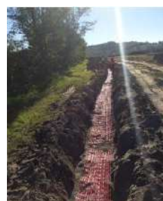
Figure 31 : Tranchée avec grillage
