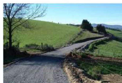
Mise en place du gravier
