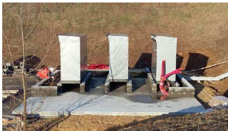
Figure 28 : Poste de transformation en construction (2 onduleurs, 1 transformateur et enveloppe béton à venir)
