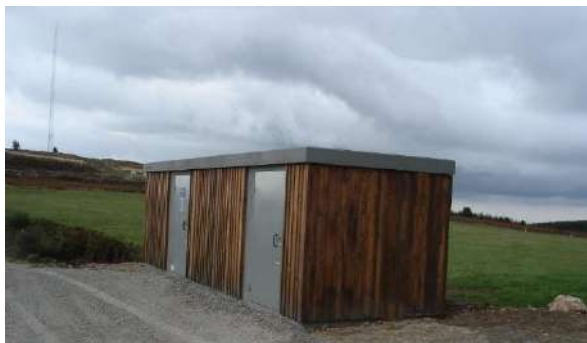
Figure 30 : Poste de livraison
