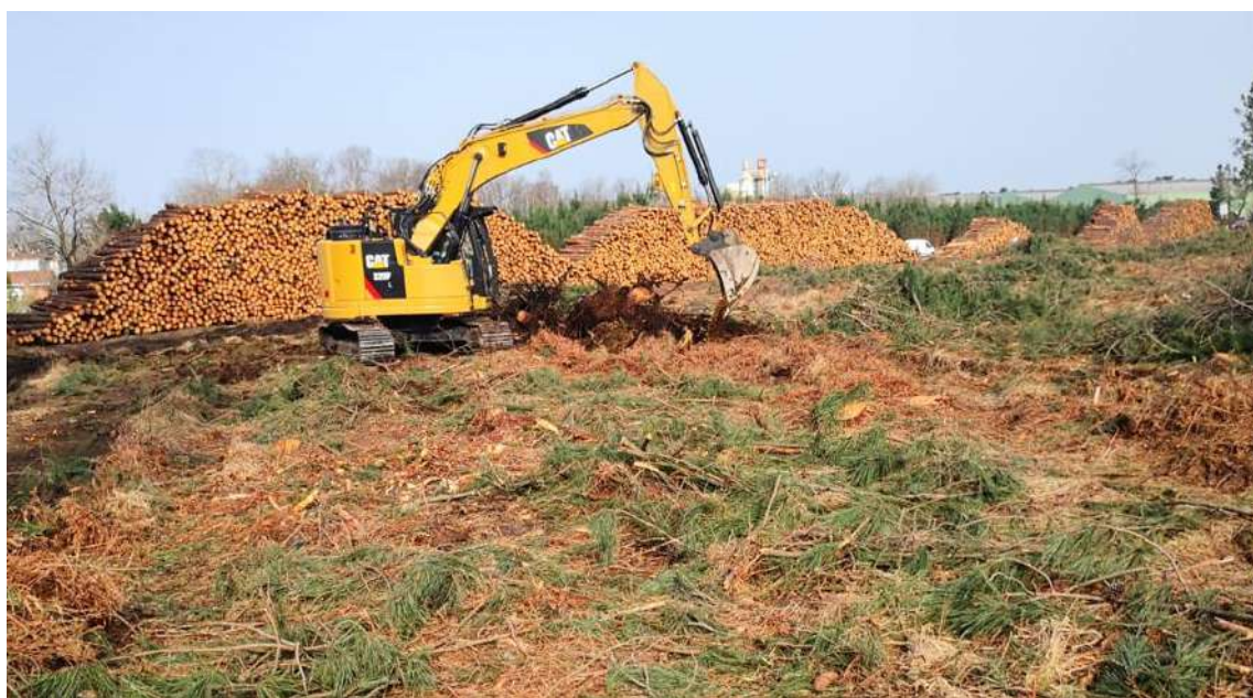
Figure 19 : Dessouchage avec pelle mécanique
