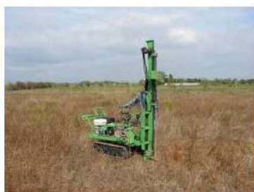
Sondage au pénétromètre
