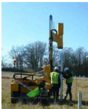
Battage des pieux
