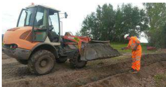
Figure 32 : Réalisation de tranchée pour enterrement des câbles
