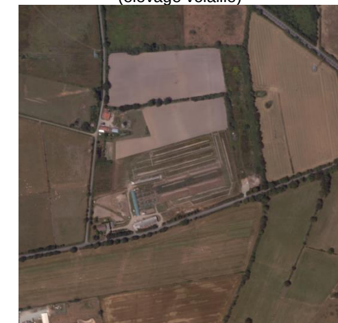
2006 : Installation des volières sur le secteur Sud et des zones de stockages bétonnée
