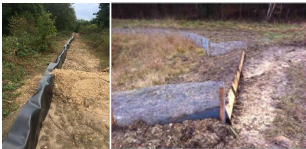
Exemple de barrière amphibiens et tremplins échappatoires (sources : Ecosphère et Ingérop)
