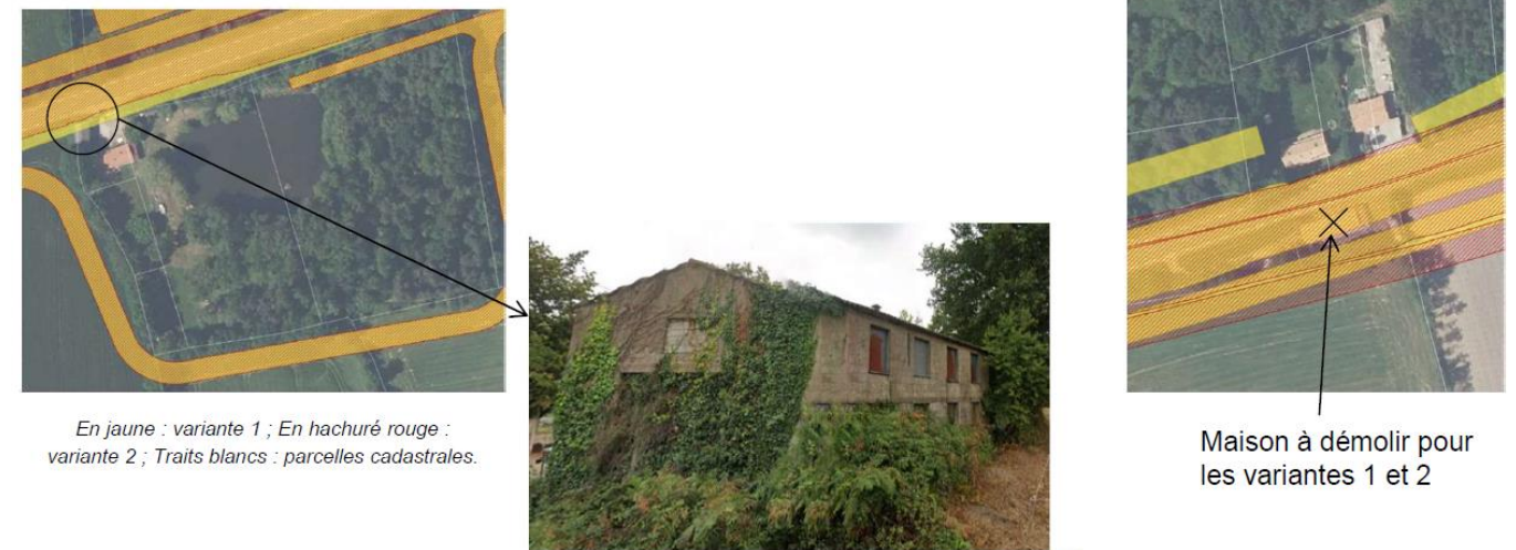
Figure 22 : Impacts sur le bâti
