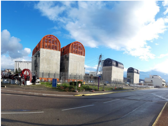
Diesels d'Ultime Secours (DUS) de 3 MWe
