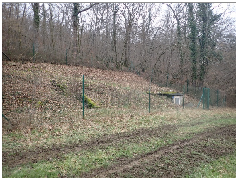
Figure 20 : Vue sur le captage de la Vallée de Nordval et son PPI (25 janvier 2023)
