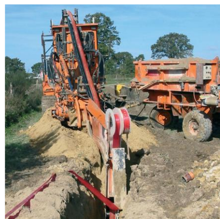
Photo 3 : Trancheuse en action
