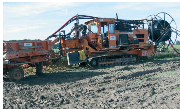
Photo 4 : Trancheuse en action
