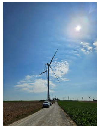
Photo 10 : Rotor assemblé au sol avant levage (Source : wpd)
