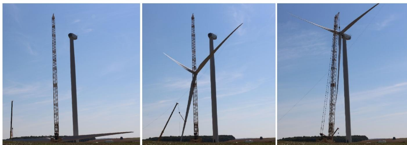
Photo 11 : Etapes du montage du rotor d'éolienne (Source : Ora environnement)
