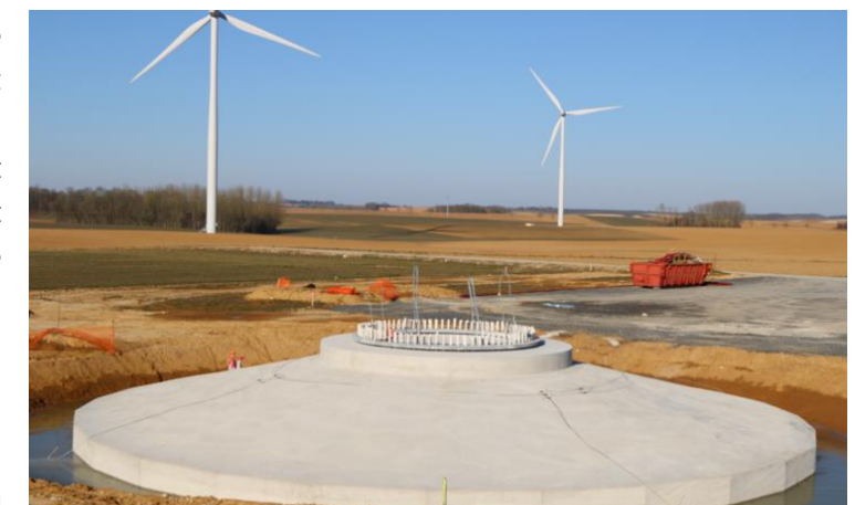
Photo 2 : Fondation avant recouvrement
