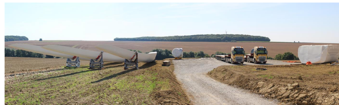
Photo 9 : Eléments d'éoliennes avant montage (Source : Ora environnement)
