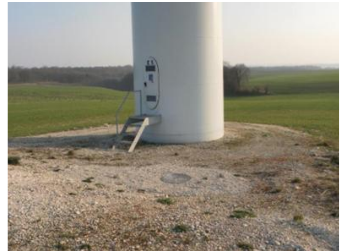
Photo 52 : Plateforme (Source : Ecosphère)
