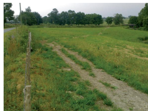
Photo 6 : Exemple de tranchée fermée depuis 2 mois
