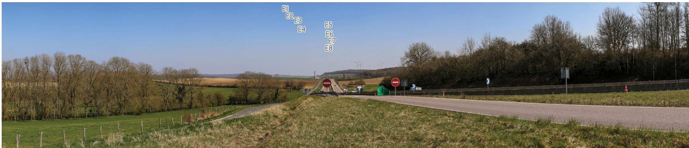
Photo 11 : PM27 : A plus de 5 km, les impacts du projet diminuent (Source : Epycart)
