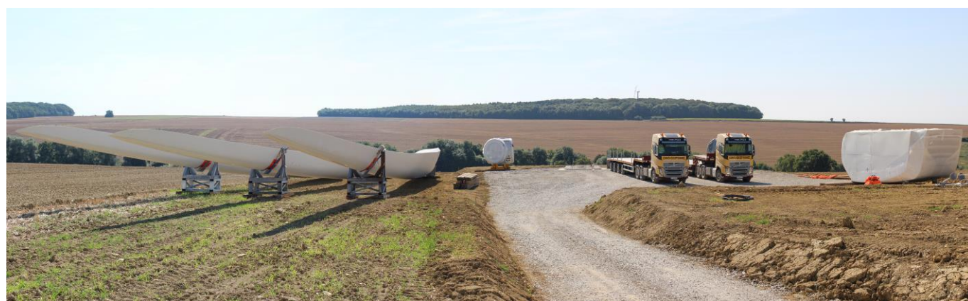
Éléments d'éoliennes avant montage (Source : Ora environnement)
