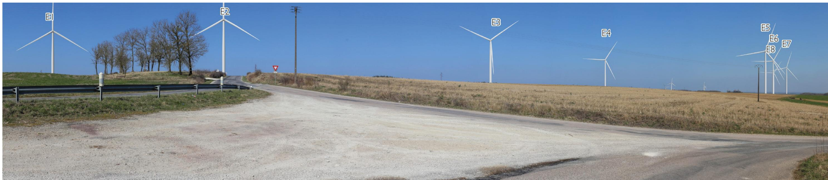
Photo 10 : PM1 : Impact très fort en sortie de Ménil-la-Horgne (Source : Epycart)
