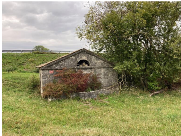
Façade du lavoir qui sera déplacé sur la place
