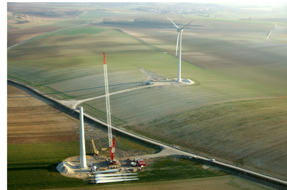
Chantier: montage d'un mât ( photo wpd)
