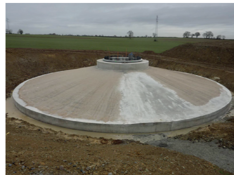
PHOTOGRAPHIE D'UNE FONDATION D'ÉOLIENNE
