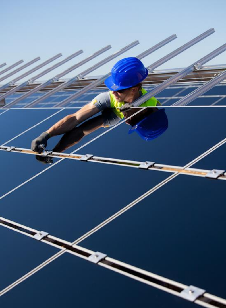
Remplacement de module (source : EDF Renewables)
