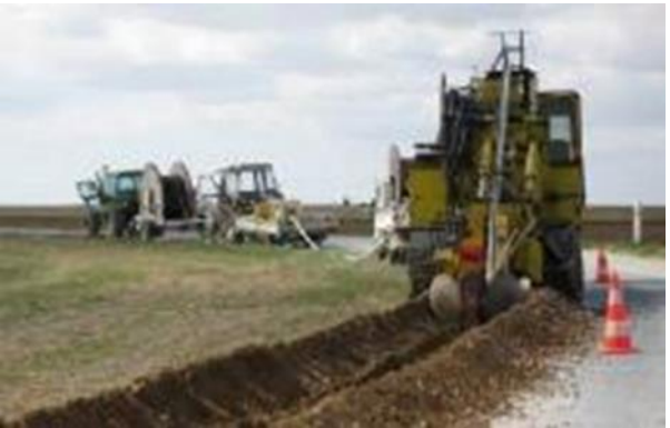
Déroutage et pose des câbles (source : EDF Renouvelables)
