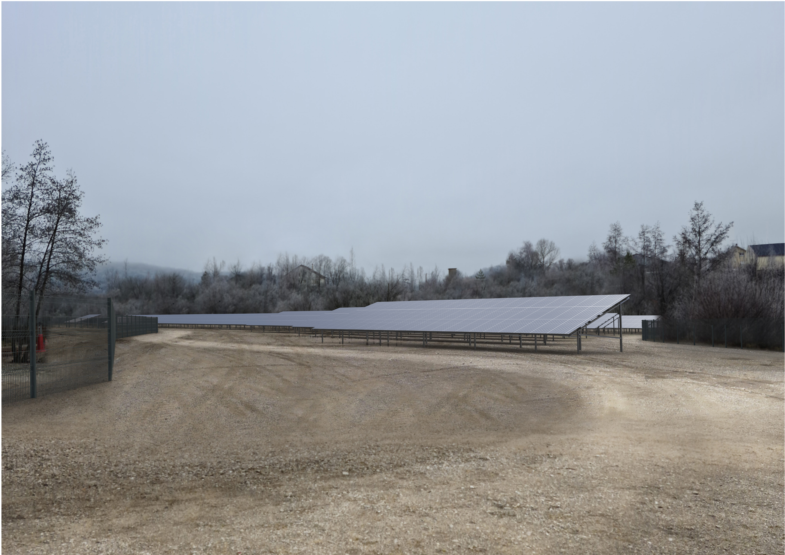
PM2 - Vue depuis l'entrée du centre équestre, en direction du Nord-Ouest
