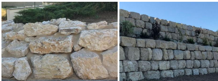
Interdiction : Blocs réguliers ou disposés de manière aléatoire et désordonnée sans jointages en pierres
