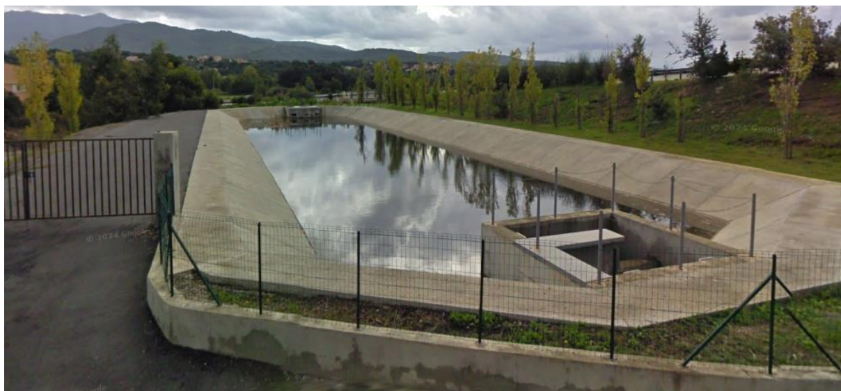
Bassin de rétention Eaux pluviales de la RT et de la route de desserte locale
