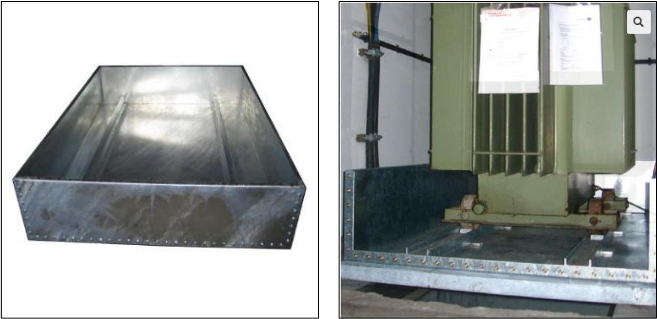
Figure 82 : Exemple de bac de rétention pour transformateur (Source : https://eurosorb.fr )
