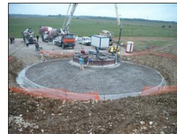
Figure 32: Étapes de mise en œuvre d'une fondation (Source : WPD)
