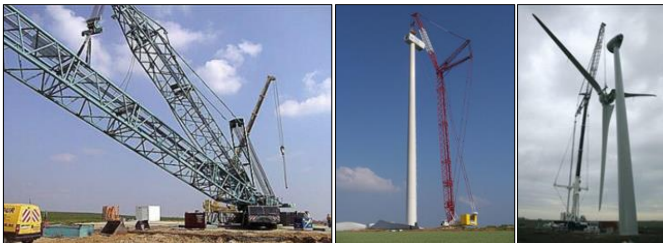
Figure 33 : Opérations de montage d'une éolienne (Source : WPD)
