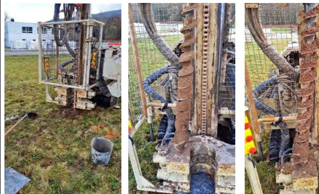
photographie du sondage
