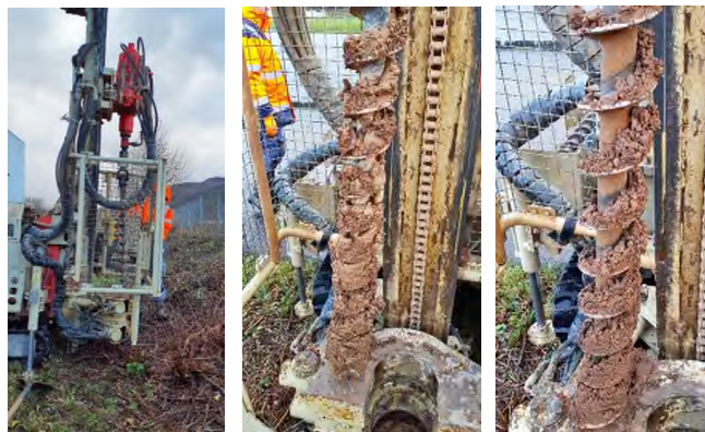
photographie du sondage
