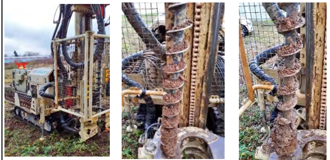
photographie du sondage
