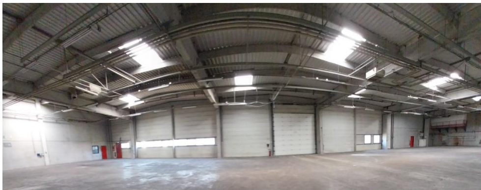
Détail de la paroi Ouest intérieure du bâtiment A
