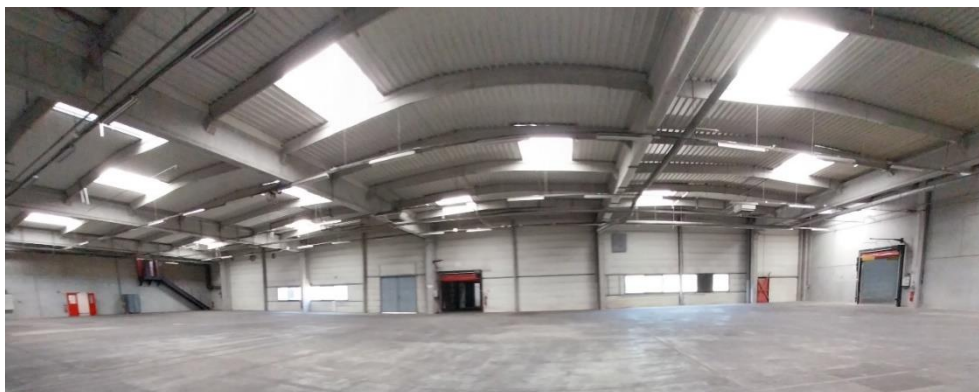
Détails de la paroi Sud intérieure du bâtiment A : Est et Ouest : mur parpaings toute hauteur
