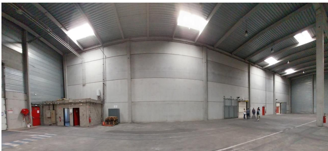
Figure 15 : Vues intérieures du bâtiment B : photographies Néodyme 06.09.2023
