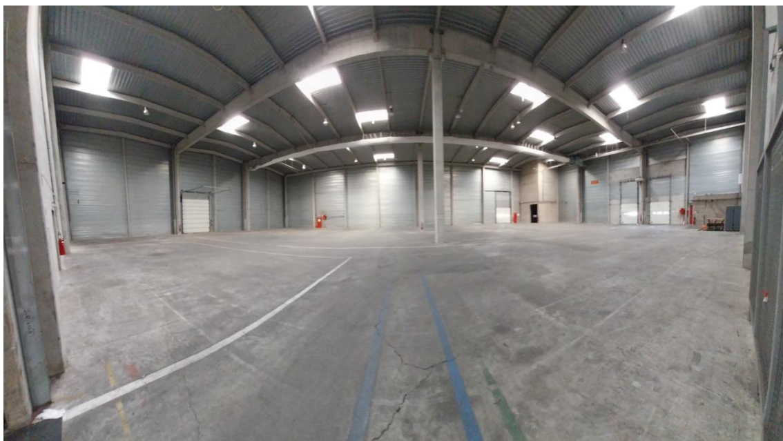
Détail de la paroi Sud du bâtiment B : mur coupe-feu 2h (à gauche le futur local laboratoire / vestiaires)
