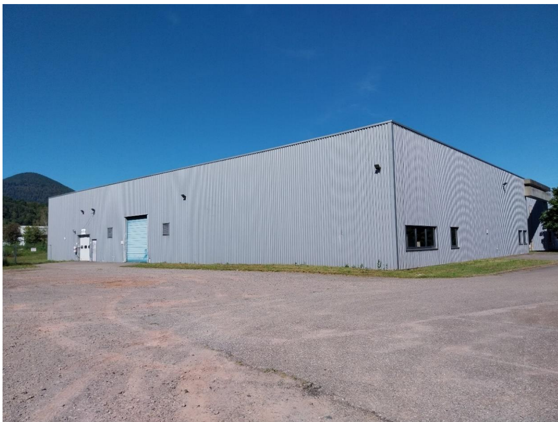
Figure 9 : Photographie illustrant les installations et équipements existants
