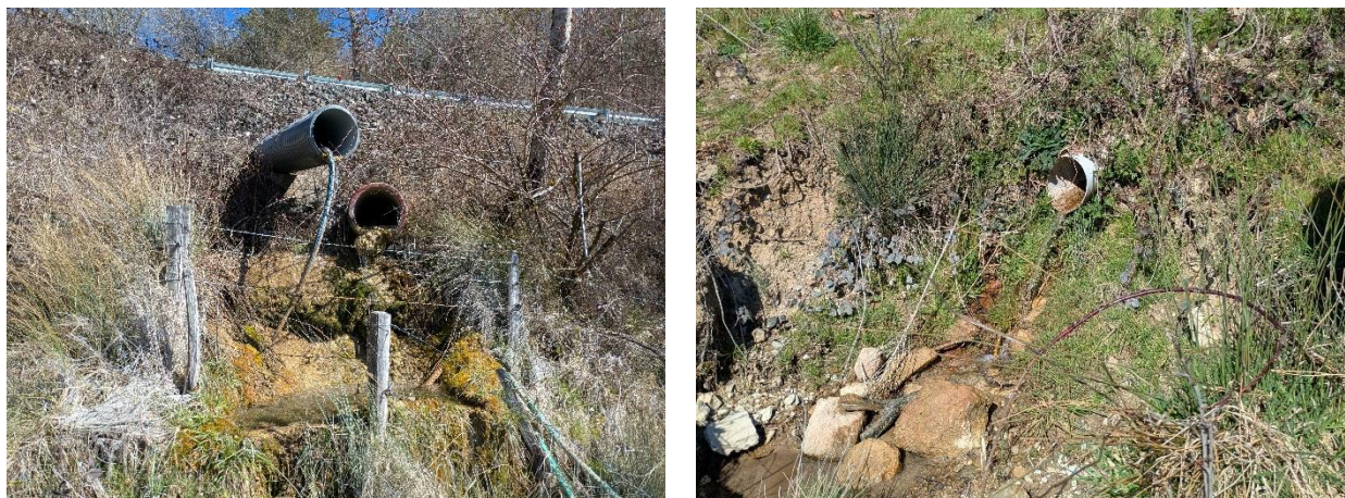
Illustration 10 : drains en contre bas de la route départementale à gauche ( Q \approx 1 \text{ m}^3/\text{h} ) et au lieu-dit Bournhous à droite ( Q \approx 1 \text{ m}^3/\text{h} ).
