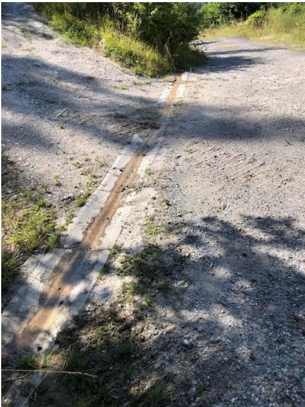
*Figure 33 : Fossé en sortie du puits de captage*
