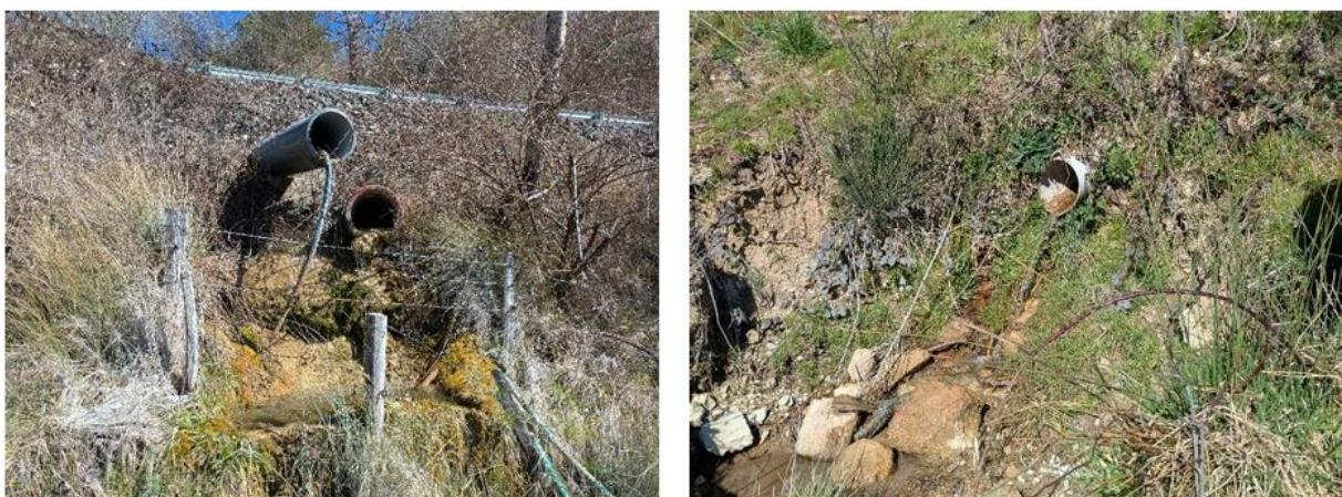
*Figure 54 : Drains en contre bas de la route départementale à gauche ( $Q \approx 1m^3/h$ ) et au lieu-dit Bournhous à droite ( $Q \approx 1m^3/h$ )*
