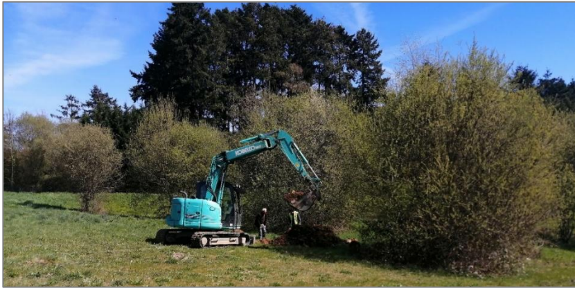
Photographie 35: Sondages géotechniques en vue d'étudier des fondations-pieux non impactantes (Source : ENCIS Environnement)
