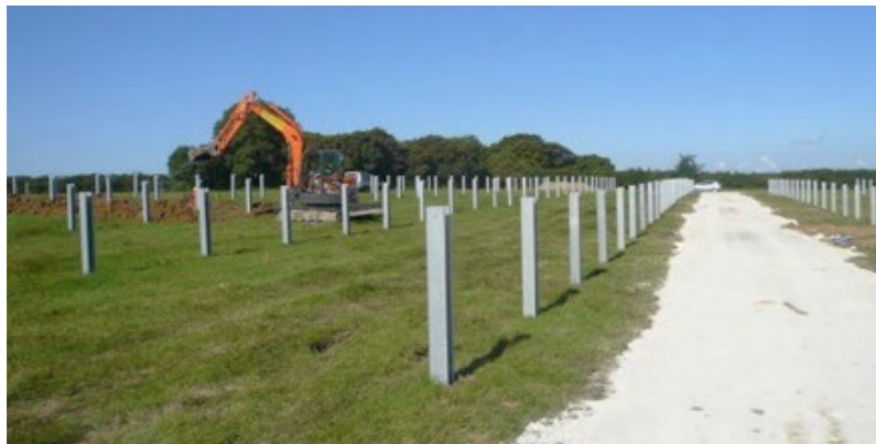
Travaux de montage des supports des modules (crédit photo :Ectare)
