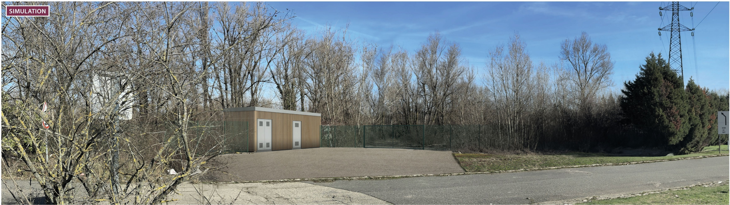
Vue rapprochée du poste de livraison
