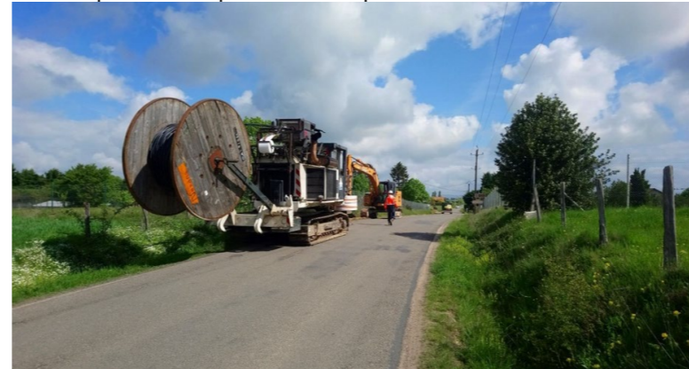
Travaux d'enterrage de câbles (crédit photo : Ectare)
