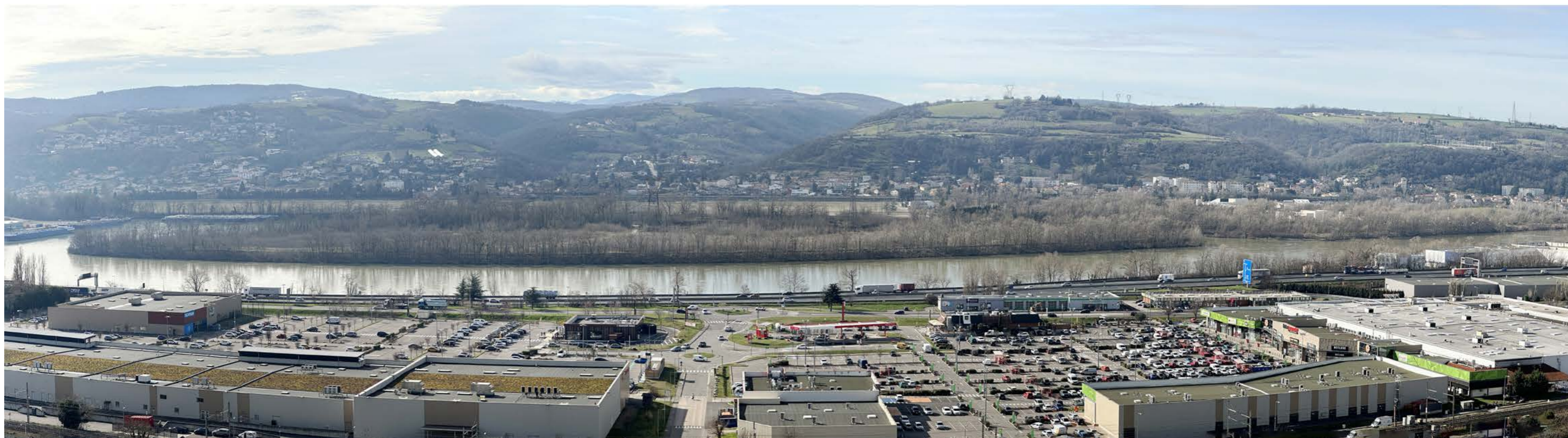
Point de vue n°2 - Vue lointaine depuis le coteau Est
