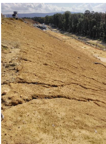
Figure 7 : érosion sur le talus sud (casier C4)
