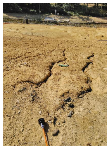
Figure 7 : érosion sur le talus sud (casier C4)
