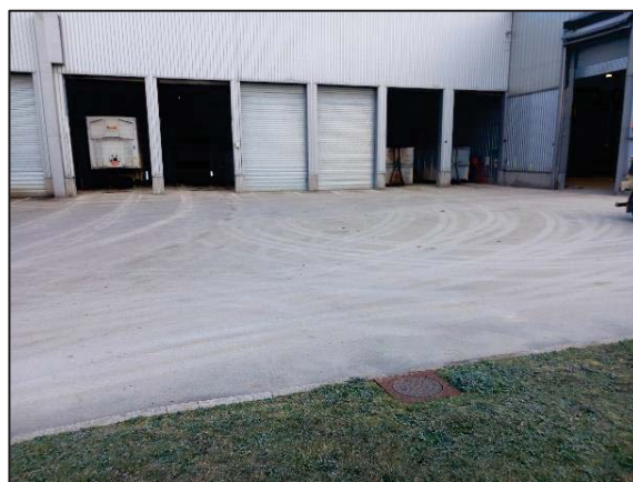
28/02/2023 : Vues générales de la zone de construction de la chaufferie
