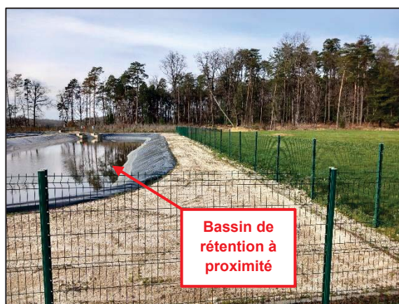
28/02/2023 : Vues générales de la zone de stockage
