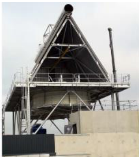
Figure 44 : Exemple d'un aérocondenseur (ACC)
