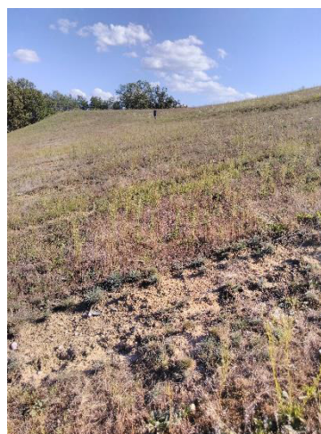
Figure 15 : talus casier C1 (couverture érodée)
