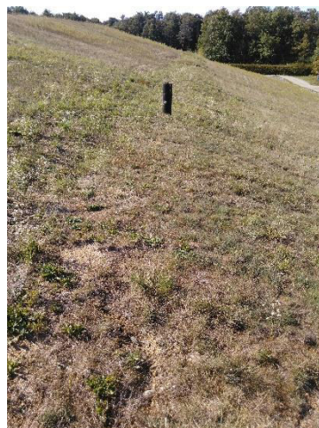
Figure 13 : fissure sur riserme du puits 95-54
