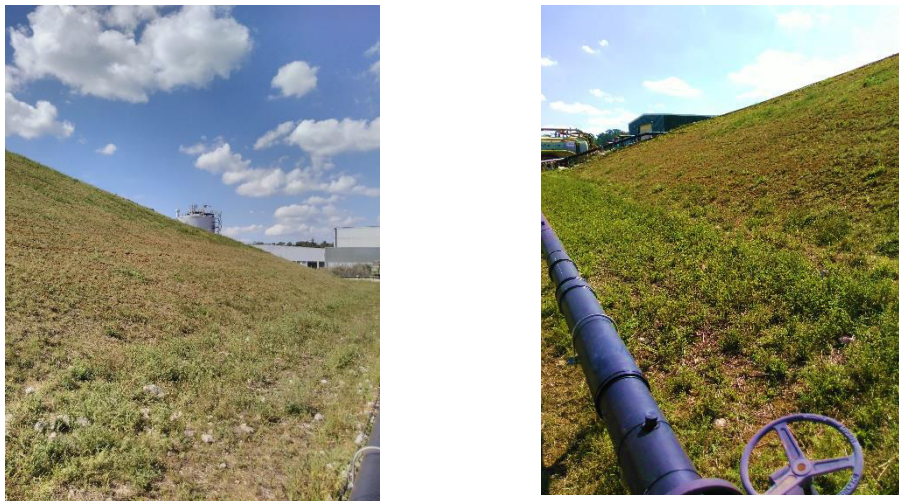
Figure 8 : vues sur le talus nord-est du casier 2
