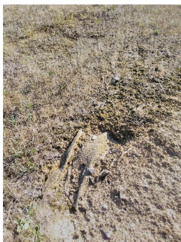
Figure 14 : talus casier C1 (géosynthétique apparent)
