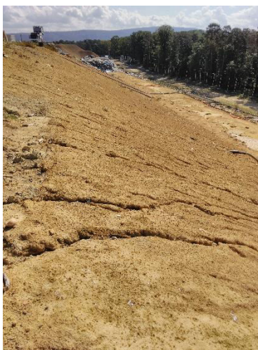
Figure 7 : érosion sur le talus sud (casier C4)
