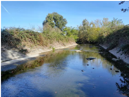
Plat courant bétonné
