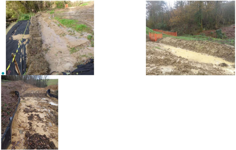
Exemples de pièges à sédiments (de gauche à droite : boudins de rétention, merlon et barrière géotextile), à privilégier le long des emprises de chantier, des cours d'eau et des zones humides (source : ARTELIA)
