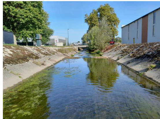
Plat courant avec recouvrement du fond par des algues
