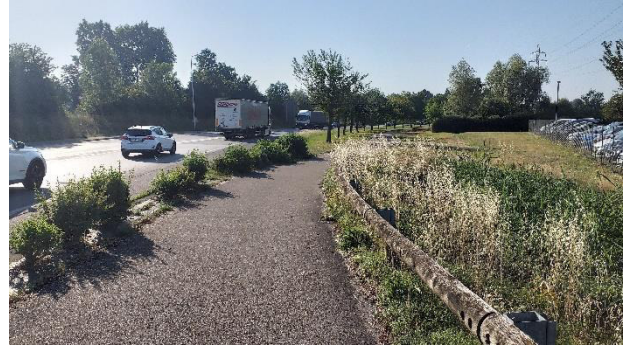
Piste cyclable le long du boulevard des crêtes de Revermont (Bourg-en-Bresse)
