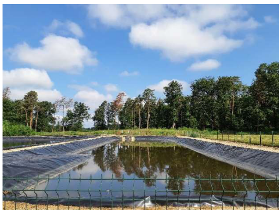
Bassin de rétention
