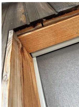
Bardage bois au niveau de la partie bureau
