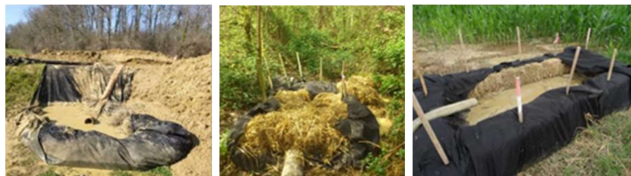
Exemples de dispositifs pour piéger un maximum de sédiments à l'exutoire de la pompe (source : ARTELIA)
