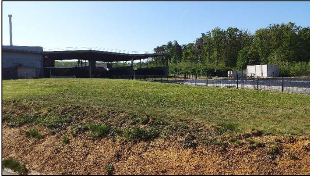
Pelouse entretenue, bassin de rétention et bâtiments de l'unité de tri
