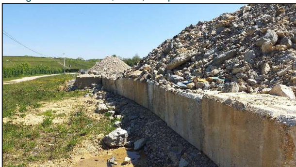
Dépôts de terres végétales
