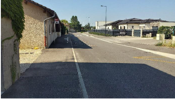
Zone fortement urbanisée, rue de Marjonas (Viriât)
