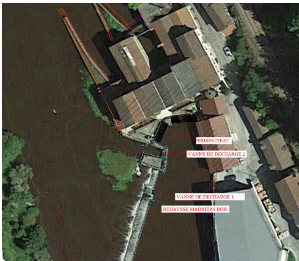
Figure 10. Localisation des vannes de décharge
