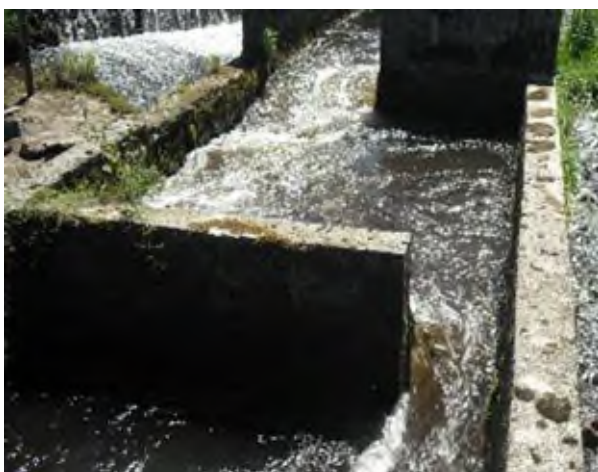
Figure 8 : Photographie de la passe à poissons existante
