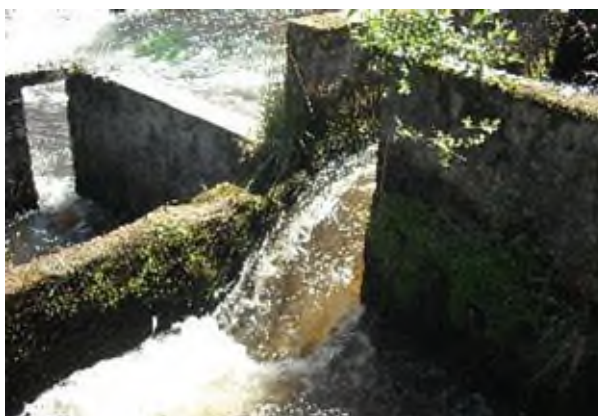
Figure 8 : Photographie de la passe à poissons existante
