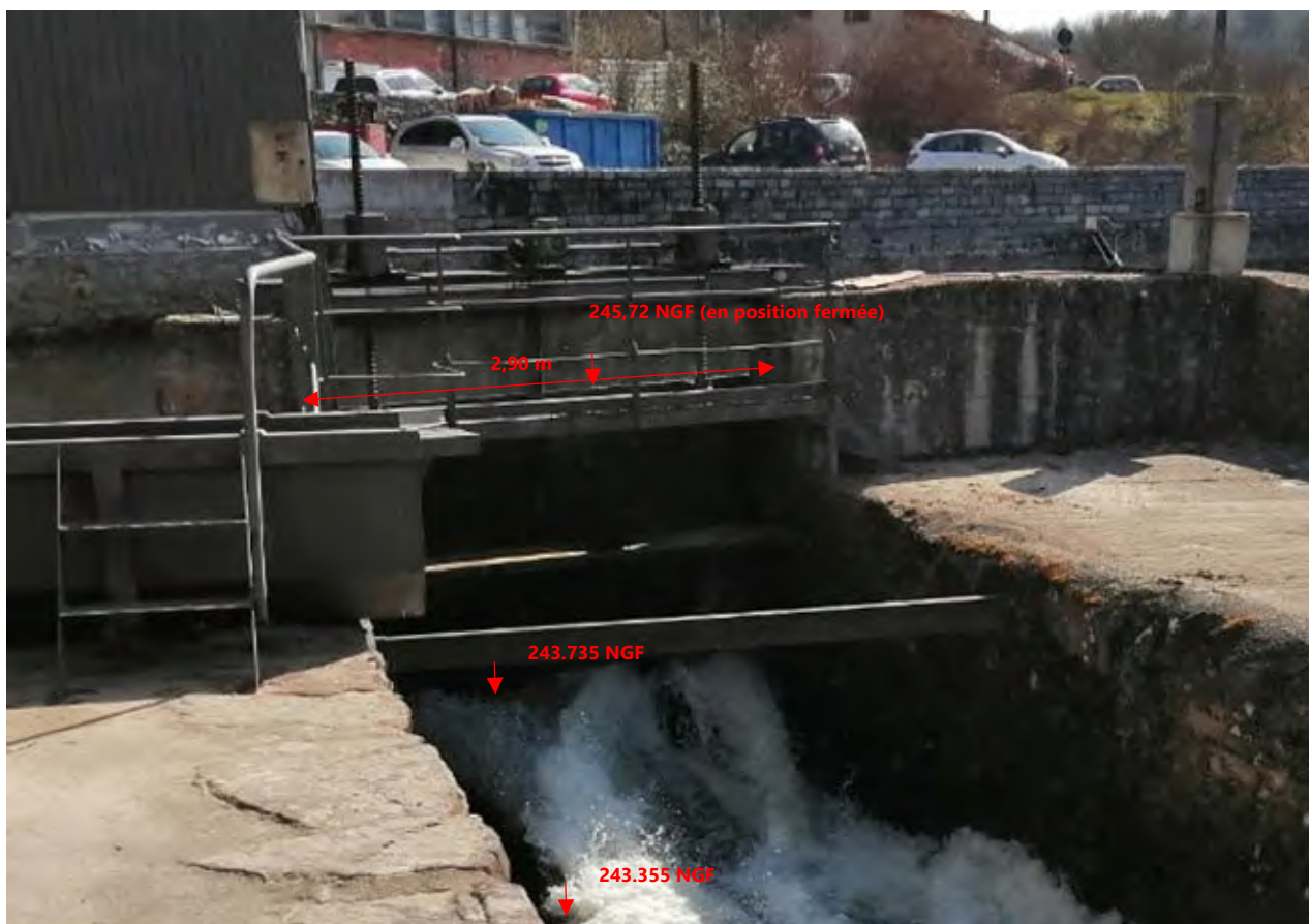
Figure 10 : vue aval de la vanne de décharge/viaange n°1
