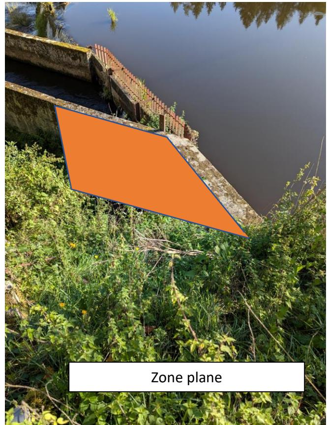
Le cheminement incliné est composé d'un revêtement stable non sensible aux mouvements d'eau ; la pente doit arriver à « 0 » à la fin de l'échelle à poissons et doit faire à minima 1,5m de largeur (idéalement 2m). Sur toute la zone en pente il peut être fixé des demi-rondins de bois tous les 50 cm afin de faciliter le glissement des bateaux sur le cheminement.
