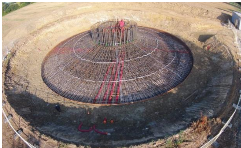
Figure 11 : Exemple de ferrailage en radier pour une éolienne (Source : VALREA)
