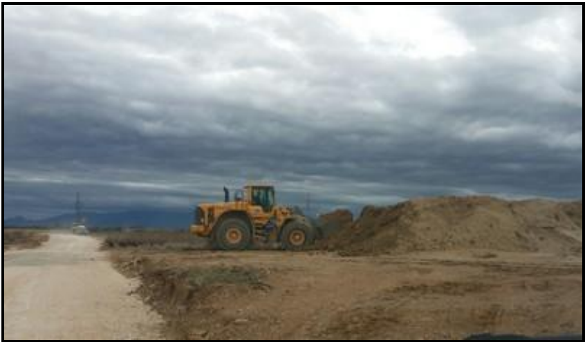
Figure 151 : Reprise de la terre stockée pour le remblayage des fondations (Source : Abies, suivi de chantier éolien)
