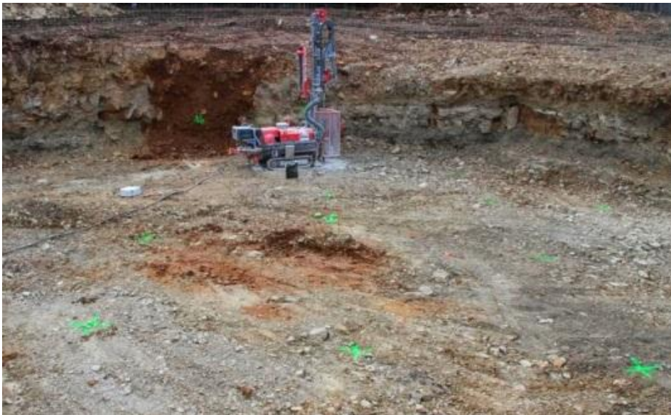
Figure 146 : Foreuse géotechnique sur un chantier éolien (Source : Abies)
