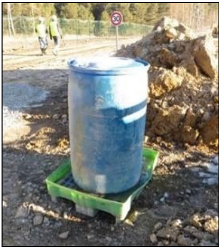
Figure 147 : Stockage d'hydrocarbures dans un bidon étanche sur bac de rétention (Source : Abies, suivi de chantier)
