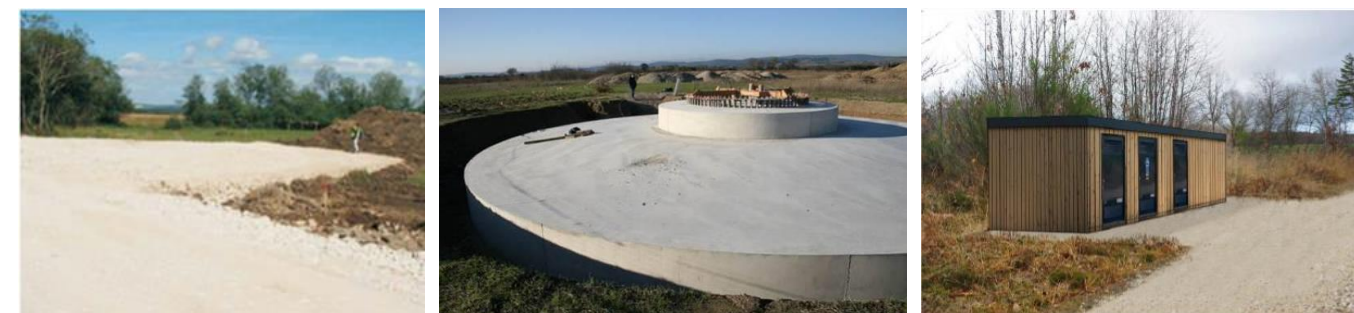
Figure 5: Aménagement des accès et des plateformes (à gauche), une fondation (au centre), et un poste de livraison (à droite)
