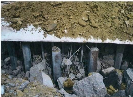
8 - Mise en place et mise à feu des explosifs pour destruction des fondations et évacuation vers les filières adaptées de gestion des déchets
