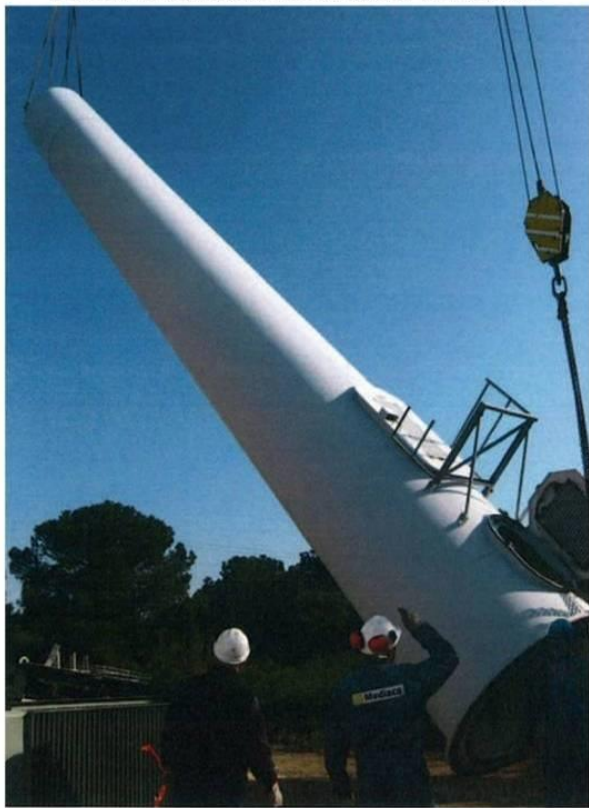
6 - Retournement avec la grue secondaire avec préparation et mise en place sur les camions navettes
