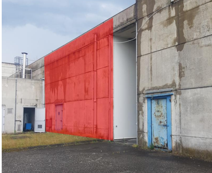
Figure 9 : Paroi du bâtiment principal traitée acoustiquement (source : TEC)
