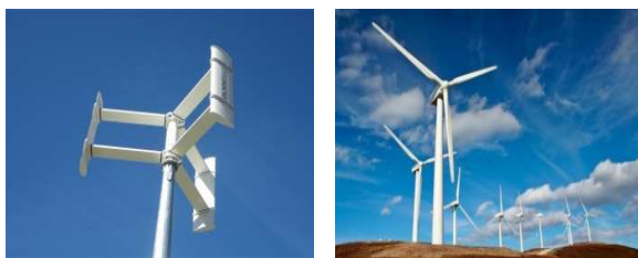
Eoliennes à axe vertical et horizontal
