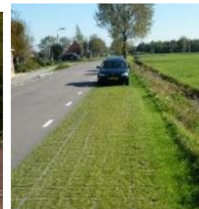
Parking enherbé (système alvéolaire).
