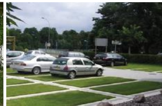
Parking enherbés – système alvéolaire
