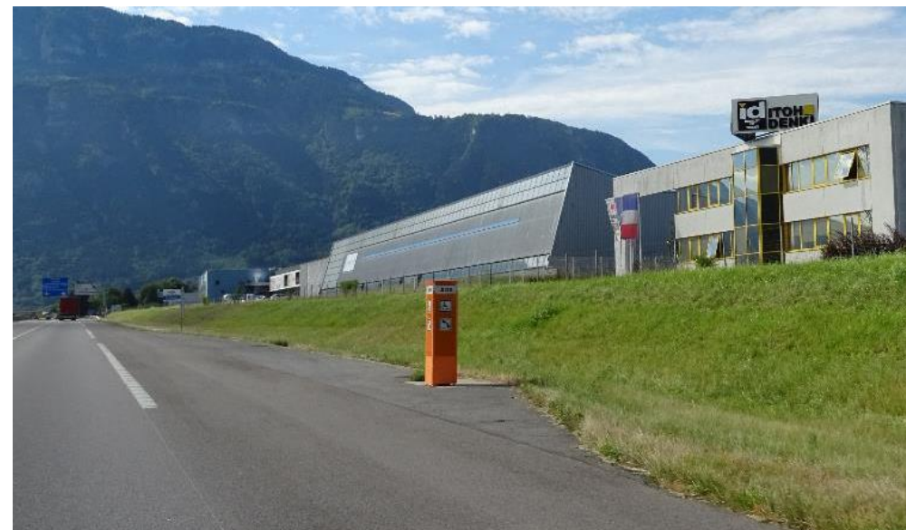
Vue du parc d'activités depuis l'A40
