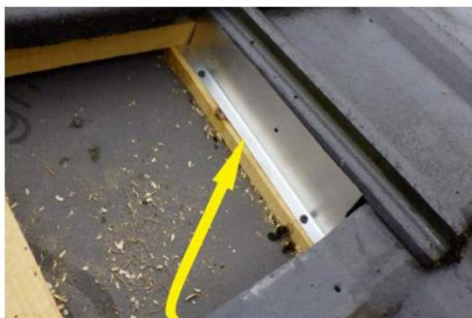
Figures 40 : Gîtes pour chiroptères adaptés aux toitures
