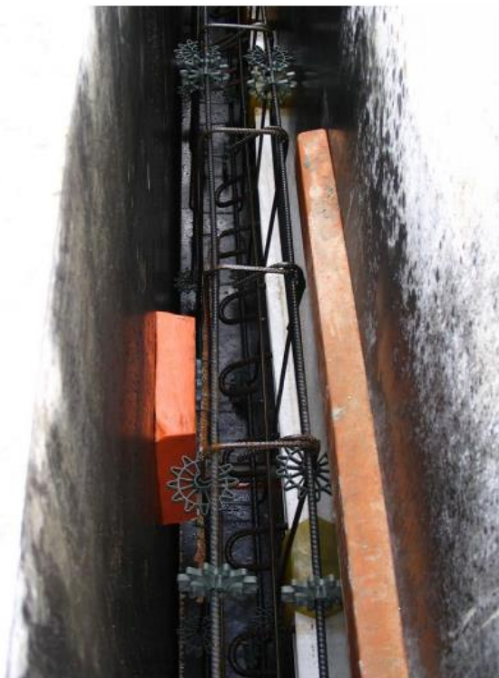
Installation de gabarits de réserve
