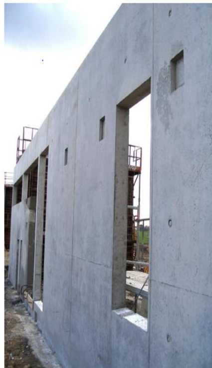
Réserves dans le béton une fois les gabarits enlevés
