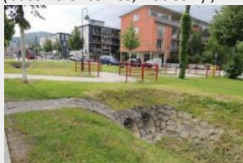
Noue pour récupérer les eaux de pluie (Source : http://collectivitesviabiles.org/articles/adaptation-aux-changements-climatiques )
