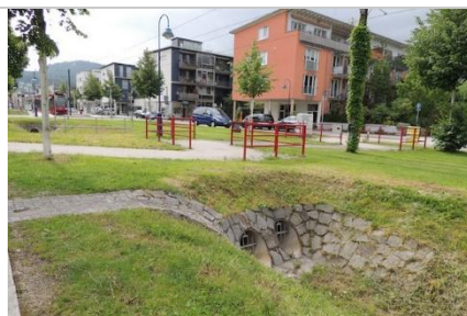
Une noue pour récupérer les eaux de pluie
