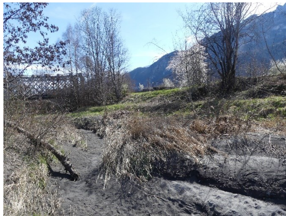
Banc aval rive gauche du pont SNCF de l'Arve où deux panneaux pourront être installés en bordure du chemin-digue
