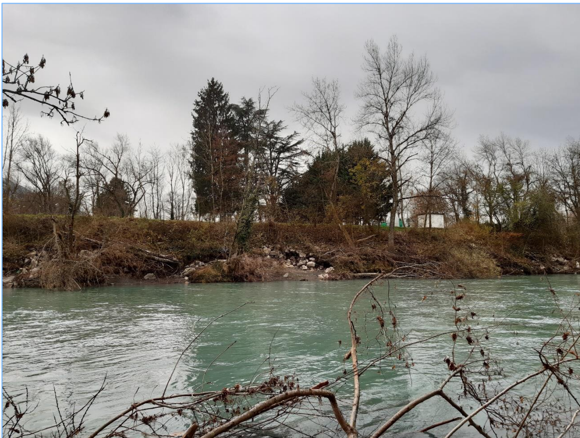
Figure 5 : Exemple d'érosion de berge en aval immédiat du pont de la prison (crue de novembre 2023)
