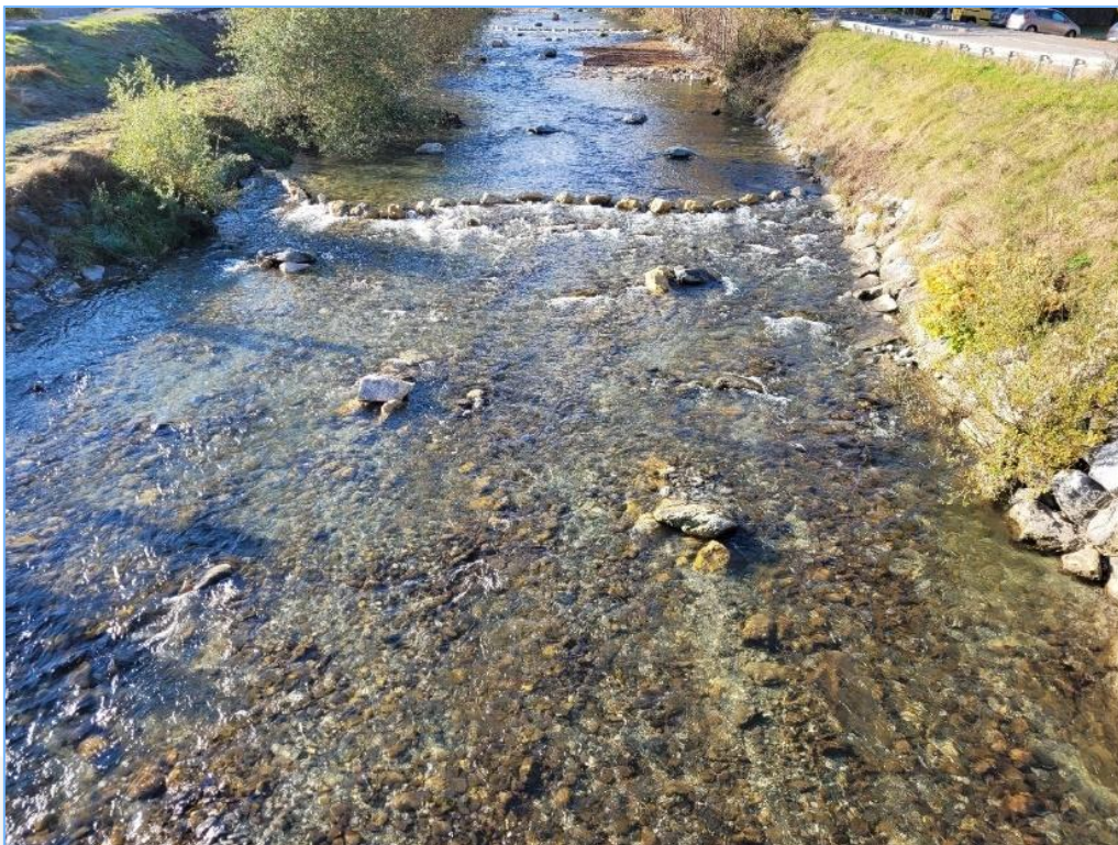
Figure 13 : Seuils perméables mis en place au niveau du Borne amont (source : ARALEP)
