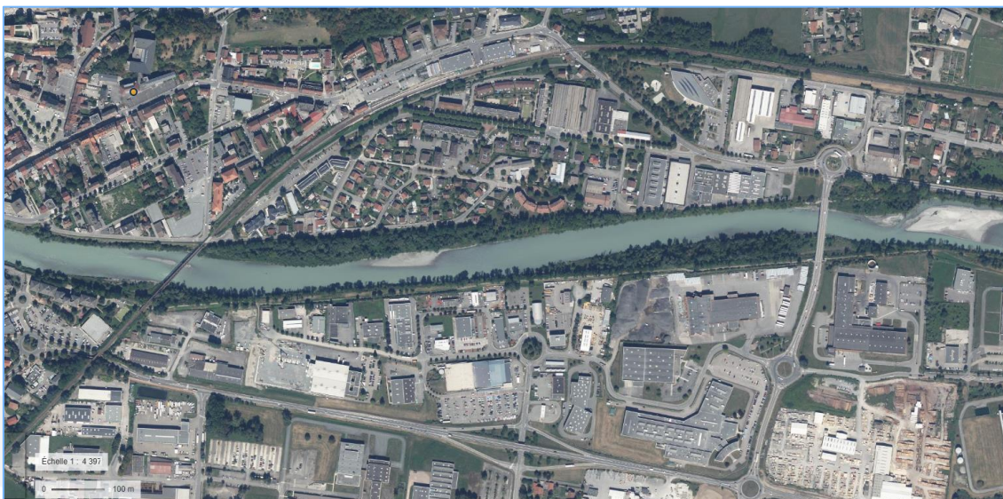
Figure 3 : Vue aérienne de l'Arve à Bonneville aujourd'hui (endiguement et développement urbain)
